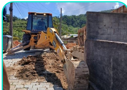
Deslocamento de rede | Alto Aririú
