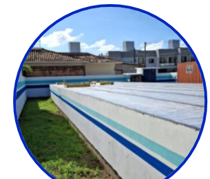
ETE Porto das Águas
