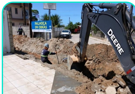
Adequação de rede | Aririú de Formiga
